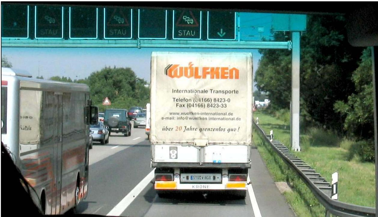
**Abbildung 4: Beispiel einer Schilderbrücke mit faseroptischen WVZ (eignes Bild)**
