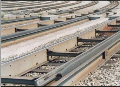
Im Anschluss an die Richtungsgleisbremsen sind die Gleise mit verschiedenen Förderanlagen ausgestattet. Langsame Güterwagen werden unmittelbar nach der Richtungsgleisbremse durch Räumförderwagen angeschoben, ein Beidrückförderwagen schiebt die Güterwagen im Richtungsgleis zusammen. Die Beidrückförderanlage ist aufgrund des Lärmschutzes erforderlich. In den Richtungsgleisen werden die Züge für die weitere Fahrt zu ihrem Ziel
