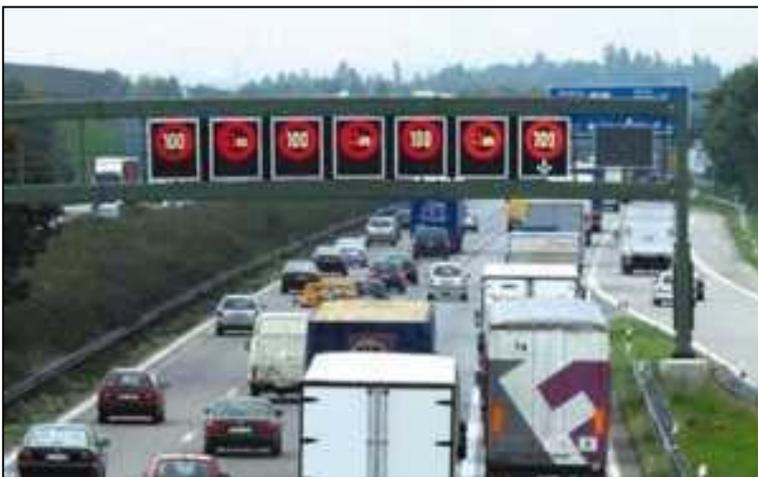
**Abbildung 7: Schaltung bei Standstreifenfreigabe (Autobahndirektion Südbayern)**
