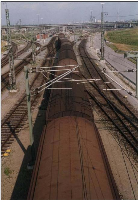
Aus den Einfahrgleisen werden die Züge über den Ablaufberg geschoben. Am Gipfel des Ablaufbergs schließt sich eine Steilrampe an und unmittelbar vor der ersten Weiche werden Gewicht und Geschwindigkeit der Wagen kontrolliert. Die erste Weiche einer Ablaufanlage ist ohne Klammerspitzenverschluss ausgestattet, so dass der zeitliche und räumliche Abstand der Wagen verringert werden kann. Damit unterschiedlich laufende Wagen nicht aufaufen ist der Rangierbahnhof mit einer Bremsenstaffel ausgerüstet.
